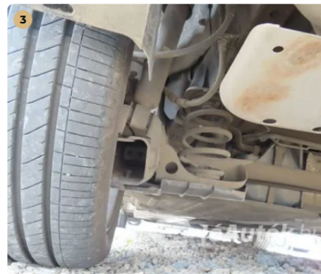
✓ Futómű A lengéscsillapítón olajfolyás nem észlelhető.
