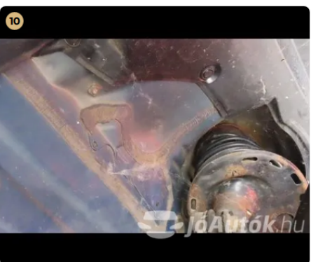
10 ✓ Utascella és gyűrődő zónák A doblemez belső oldalán deformálódás nyomai nem találhatóak. -
